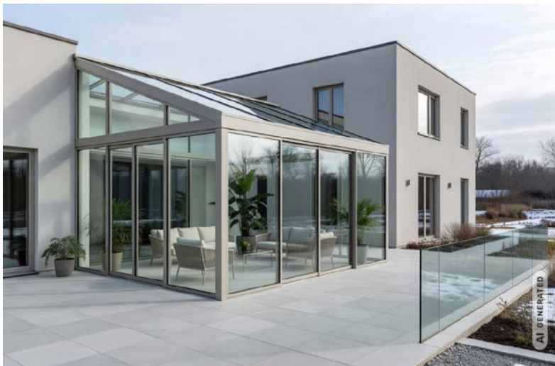
Die Tragwerkskonstruktion der meisten Wintergärten werden aus Aluminium gebaut.
